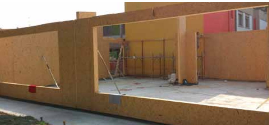
Le aule in costruzione
