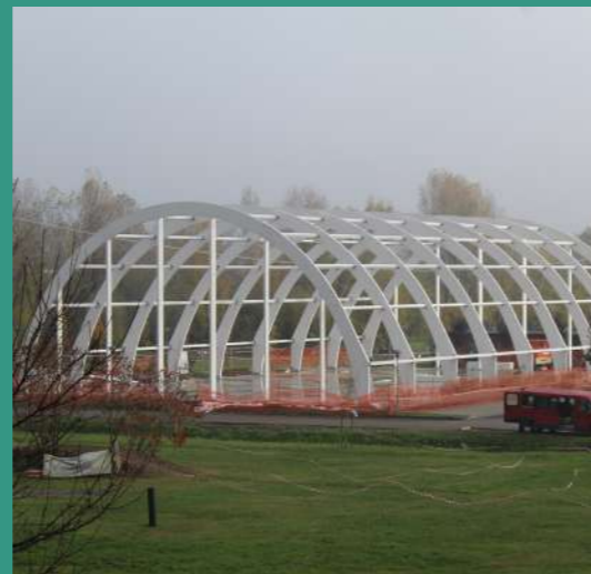
Foto: Lo scheletro della copertura della palestra in via Ghiarelle
