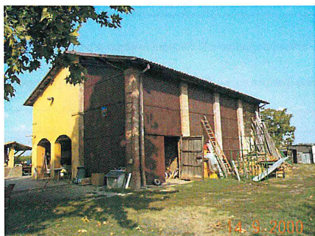
Edificio C/D vista da sud ovest
