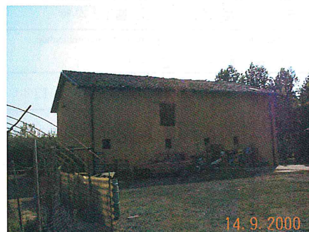
Edificio C/D vista da nord
