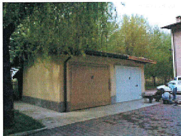
Edificio E vista da sud est
