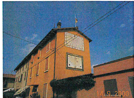
Edificio A vista da sud ovest
