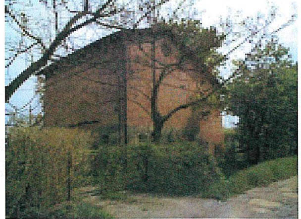
Edificio C/D: vista da ovest
