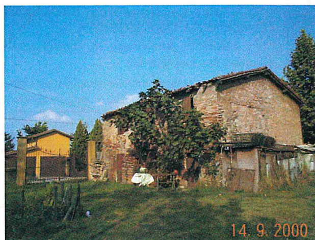
Edificio F vista da sud
