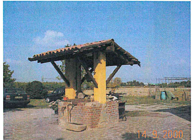
Pozzo: vista da ovest
