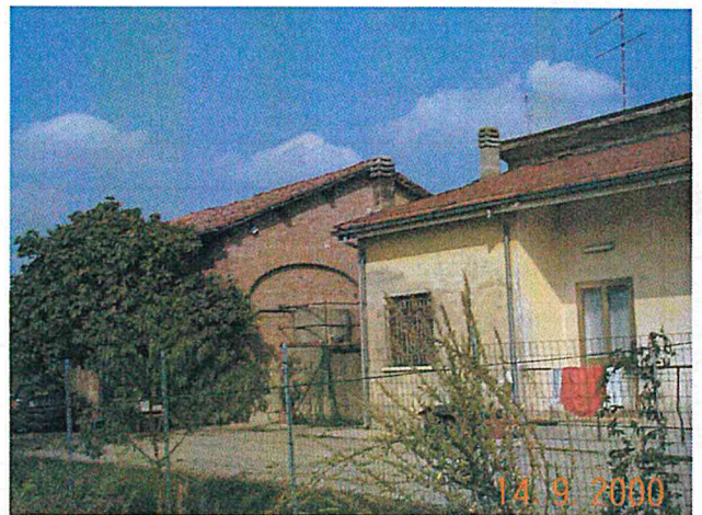
Edifici A e D vista da sud ovest
