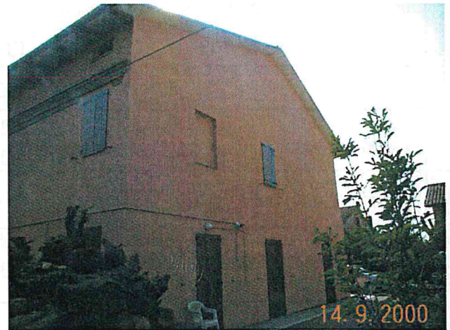
Edificio A vista da nord ovest
