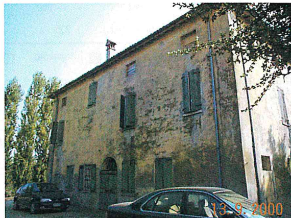
Edificio A2 vista da nord ovest
