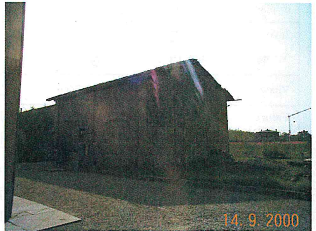
Edificio D vista da nord ovest
