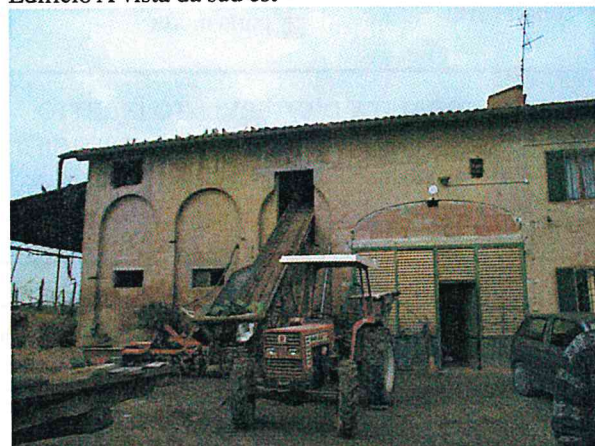
Edificio C/D vista da sud
