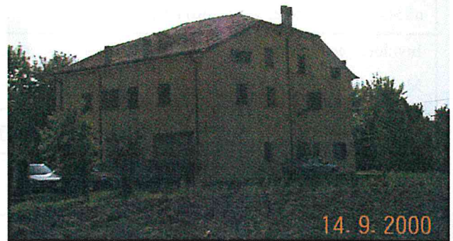
Edificio A vista da nord est
