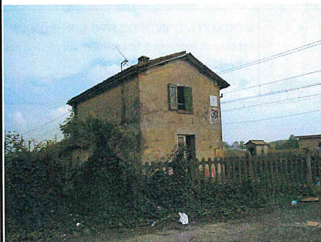
Edificio A vista da nord ovest
