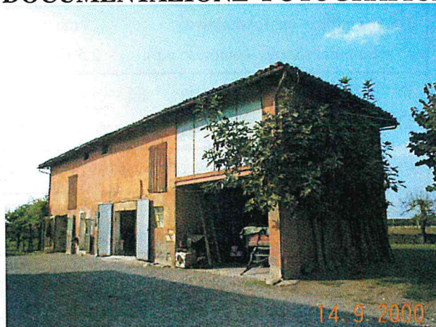
Edificio D vista da est
