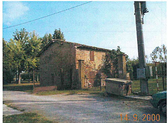
Edificio F vista da vest
