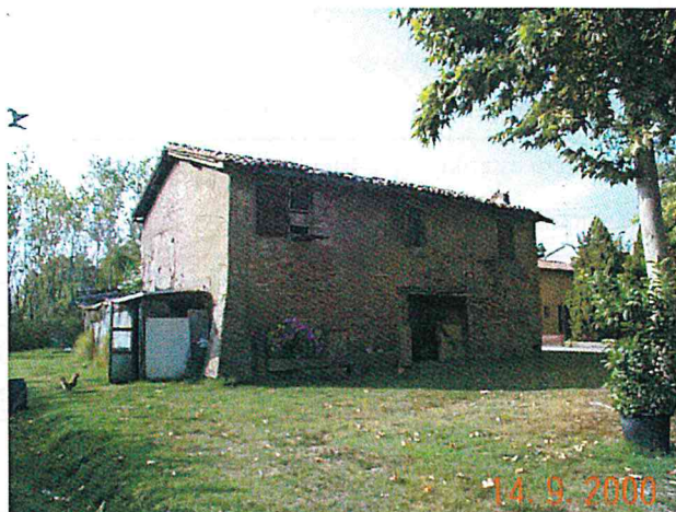
Edificio F vista da sud est
