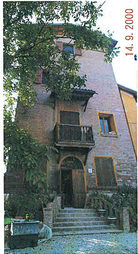
Edificio A vista da vest
