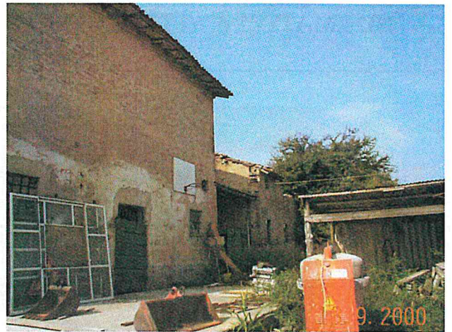
Edificio vista da nord est
