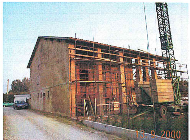
Edificio A-B vista da nord ovest
