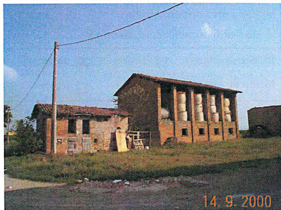
Edificio F e C/E vista da ovest
