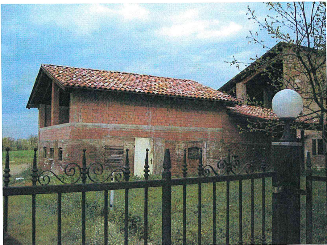
Fabbricato F (Rilievo fotografico dell'aprile 2004)
