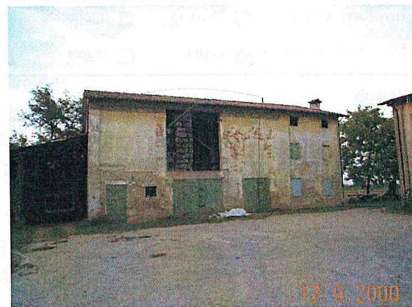
Edificio A/C vista da est
