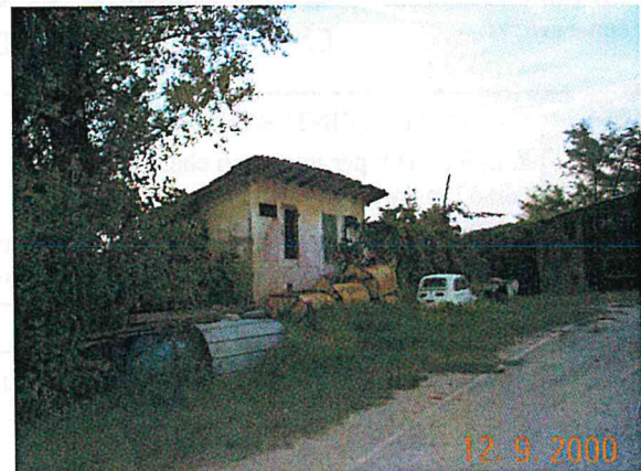
Edificio F vista da sud
