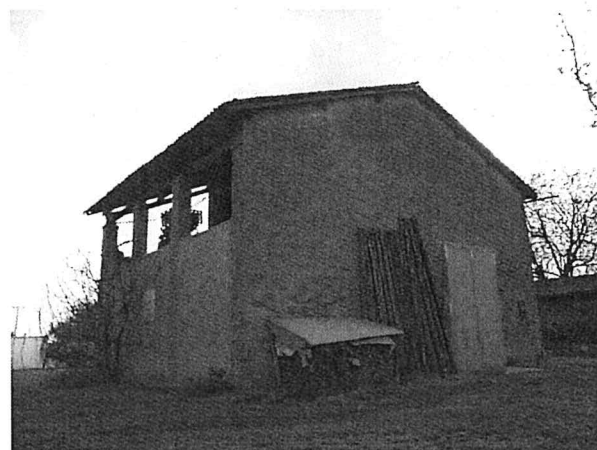
Edificio C/D vista da nord
