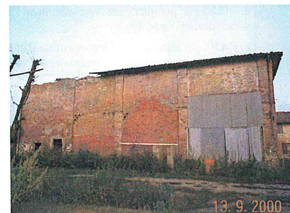
Edificio C/D vista da ovest
