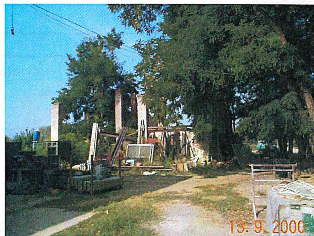
Edificio C/D vista da sud est
