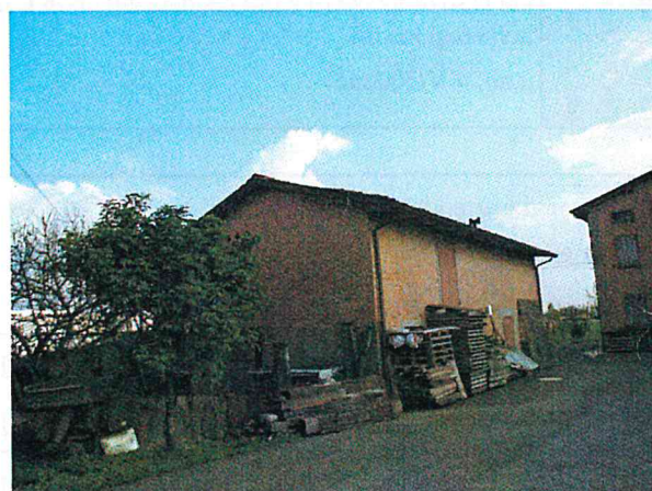
Edificio B vista da nord
