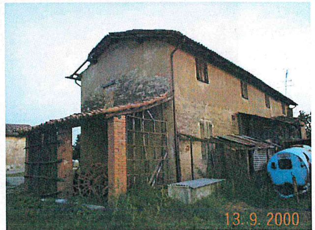
Edificio A2 vista da nord ovest
