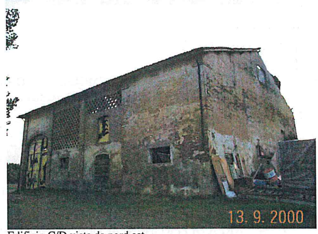
Edificio C/D vista da nord est
