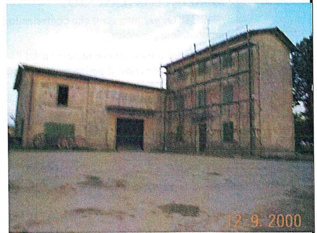
Edificio A/H vista da nord ovest
