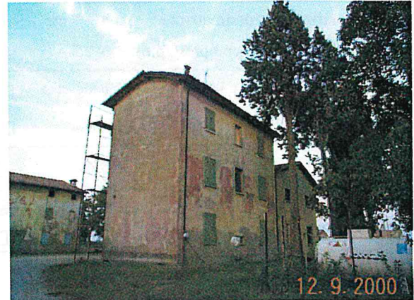
Edificio A vista da sud ovest
