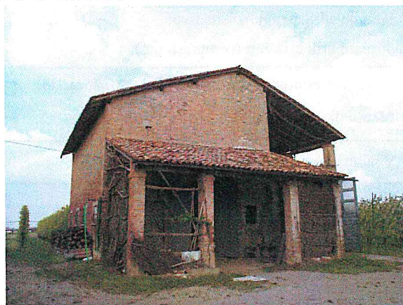
Edificio C/D vista da sud
