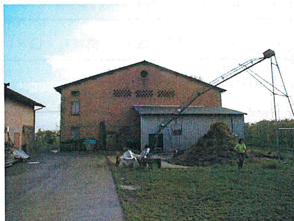
Edificio A e C/D vista da nord
