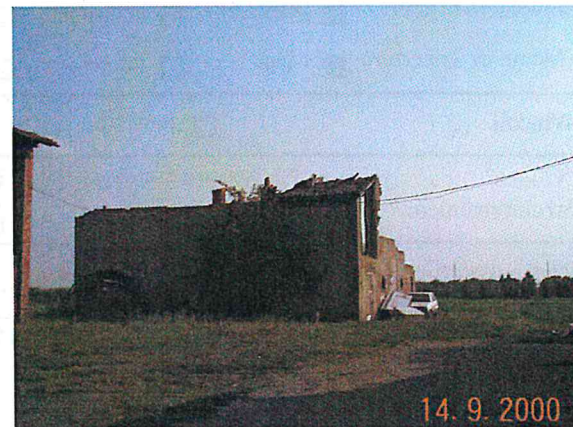
Edificio C/D vista da nord
