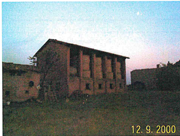
Edificio C/E vista da nord
