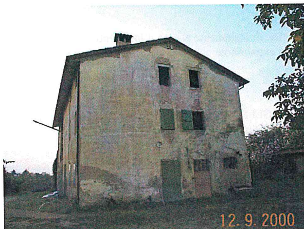
Edificio A/C vista da est
