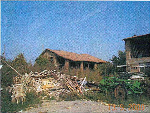
Edificio C/D1 vista da sud est
