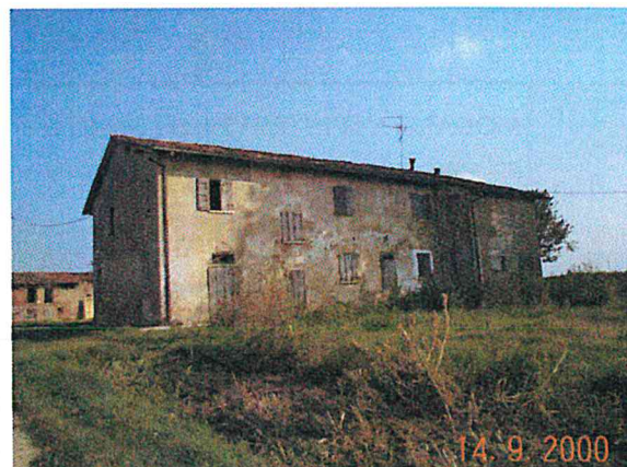
Edificio A vista da ovest
