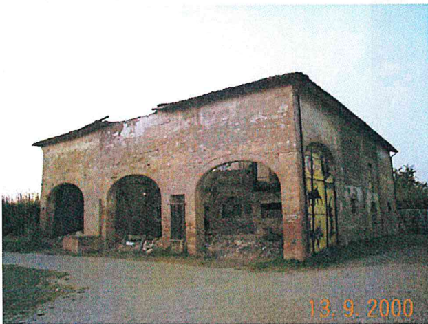
Edificio C/D vista da sud est
