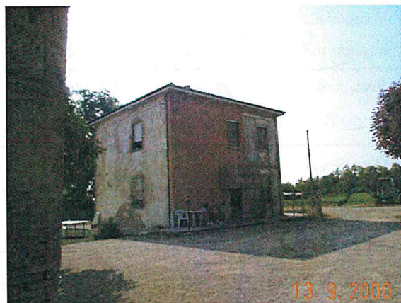
Edificio A2 vista da nord est
