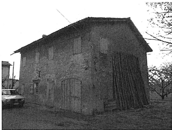
Edificio C/D vista da nord
