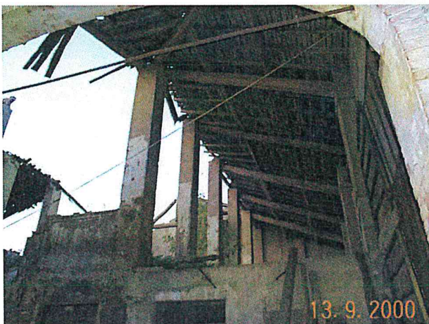
Edificio C/D vista da sud interno
