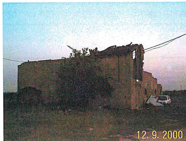
Edificio C/D vista da nord
