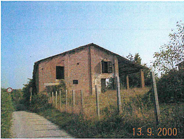
Edificio C/D1 vista da sud
