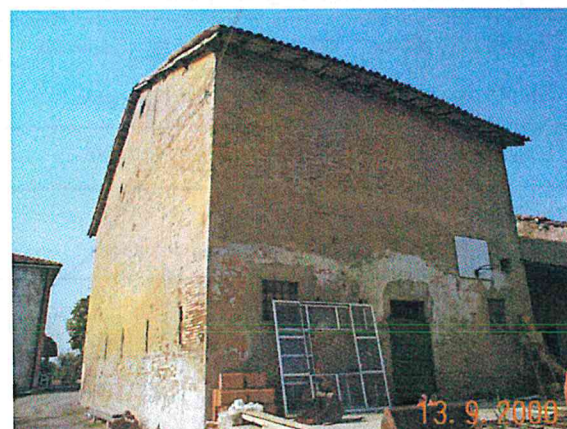
Edificio C/D2 vista da nord est
