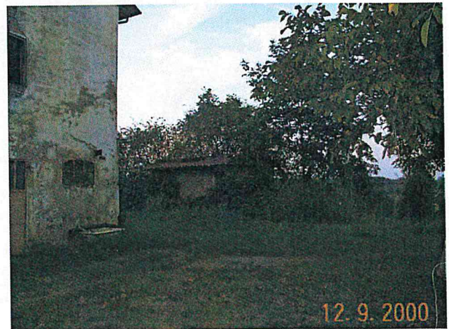
Edificio F vista da sud
