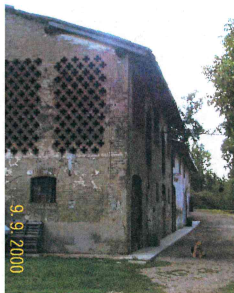
Edificio C vista da nord est
