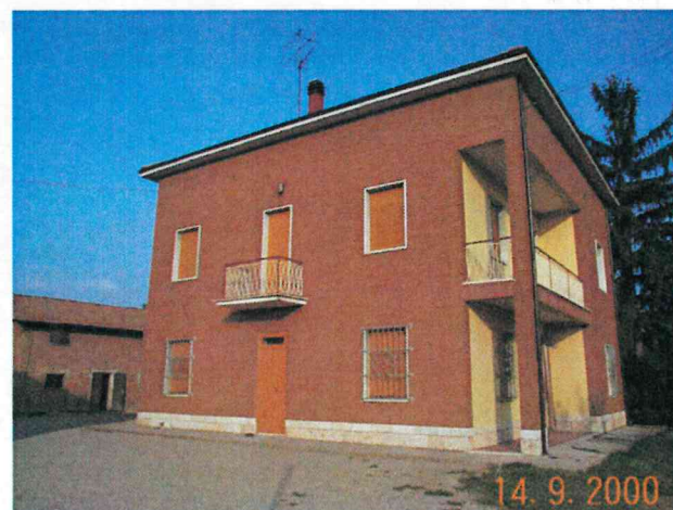
Edificio A vista da sud ovest
