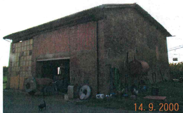
Edificio C/D vista da nord est
