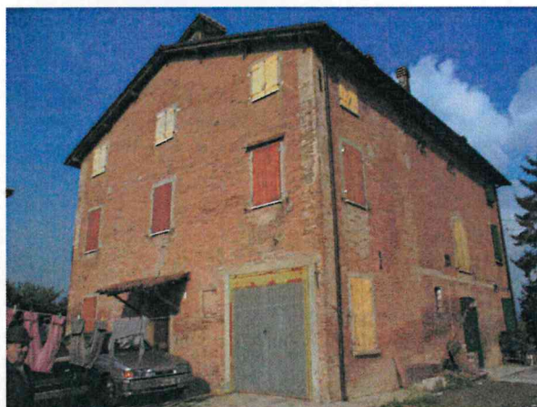
Edificio A vista da sud ovest
