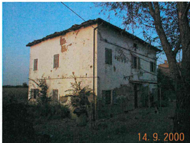
Edificio A vista da sud ovest
