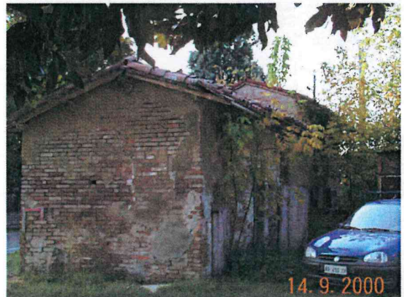
Edificio F vista da est
