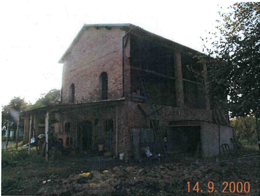
Edificio B1 vista da nord est
