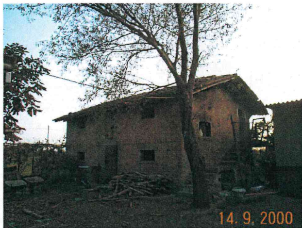
Edificio F vista da est
