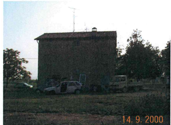
Edificio A1 vista da nord est
