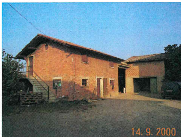
Edificio F vista da sud ovest
