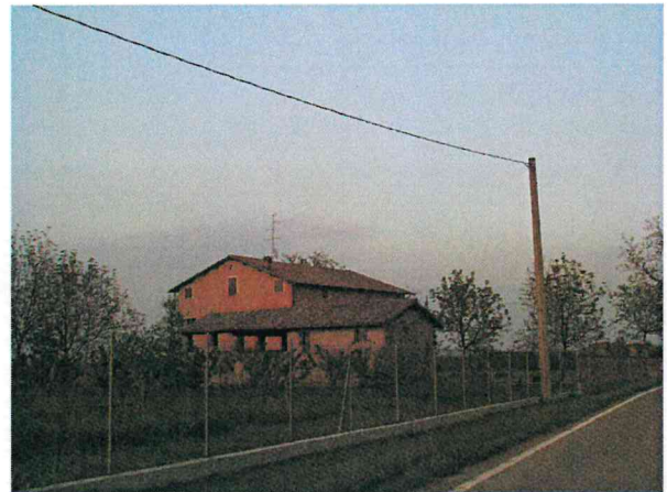
complesso vista da ovest
