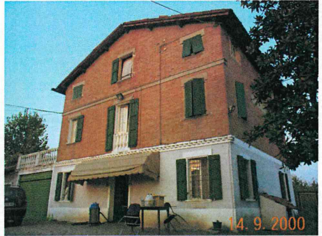
Edificio A vista da sud ovest
