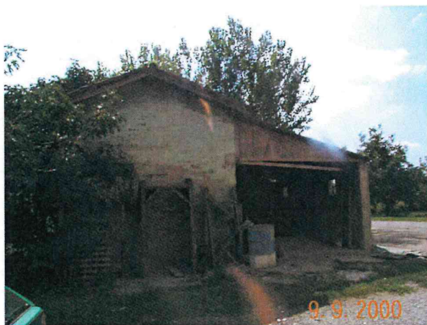
Edificio F vista da nord
