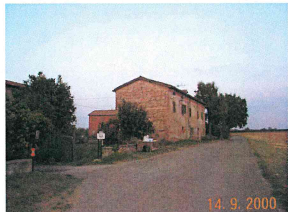
Edificio A2 vista da ovest
