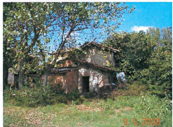
Edificio F vista da sud
