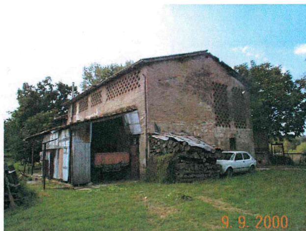
Edificio C vista da nord est
