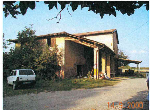
Edificio A2 vista da sud ovest
