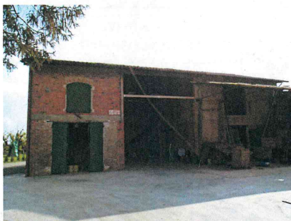
Edificio B vista da nord
