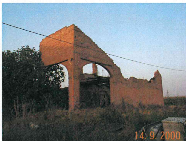
Edificio C/D vista da sud ovest
