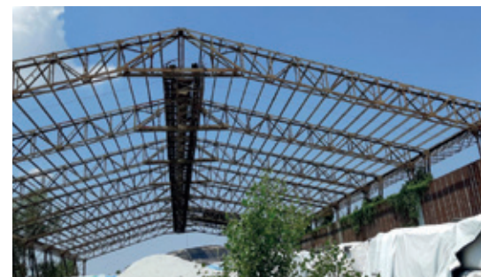
Foto: La tettoia del sito di via Bonvino bonificata dall'amianto
